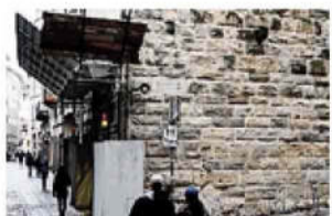
Le protezioni sulla torre
