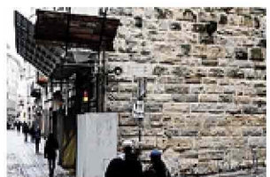
Le protezioni sulla torre
